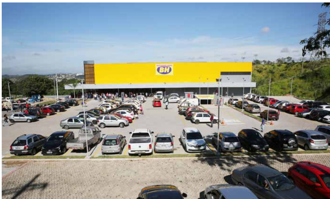
Vista externa de loja da rede Supermercados BH recentemente inaugurada em Betim (MG)
