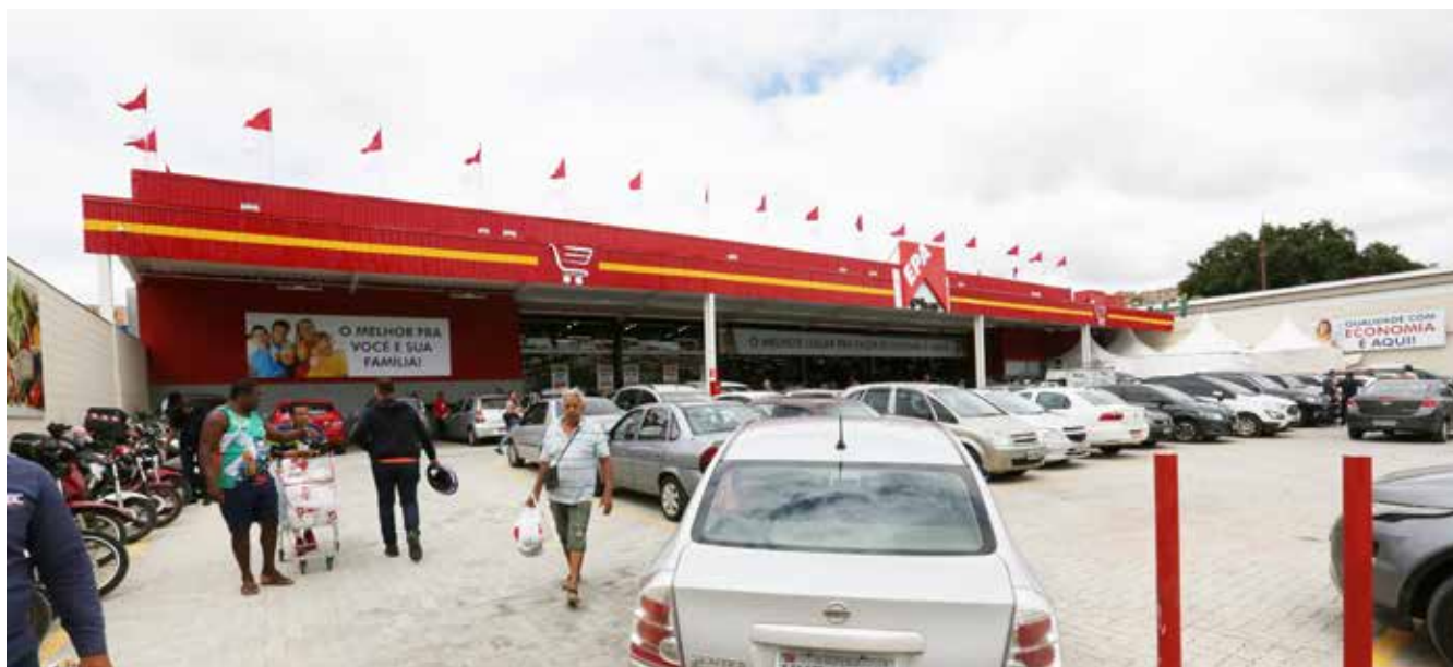
Vista externa de loja EPA, em Belo Horizonte
