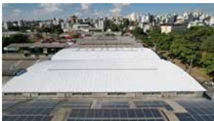
tos climáticos, tais como as ações do vento e principalmente o minério de ferro que afeta a região, ocasionando oxidações e desgastes nos telhados. A pintura térmica final garante a proteção do sistema de impermeabilização, aliada ao conforto térmico para os clientes e colaboradores, com sustentabilidade. De acordo com o Diretor, Gustavo Percope, “além da loja finalizada do Jardim Canadá, a Gestão Engenharia está trabalhando em mais seis unidades dos Supermercados BH
